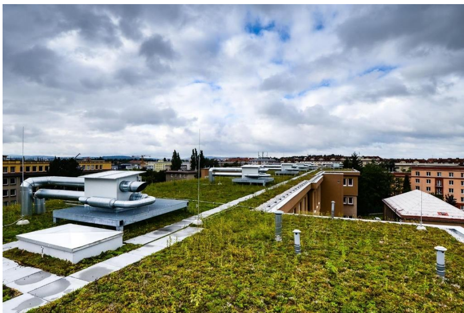
Obrázek 23 Zelená střecha na nástavbě budovy 20. základní školy v Plzni Zdroj: město Plzeň (dostupné zde )
